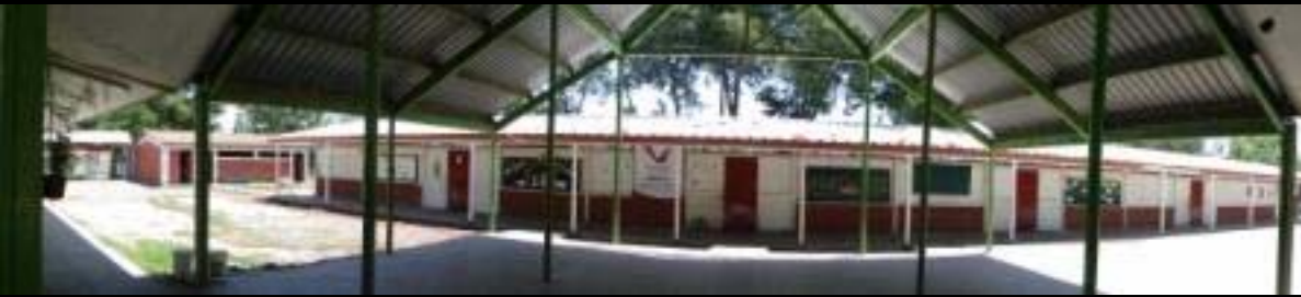
REPARACIÓN ESCUELA LAS ARBOLEDAS
