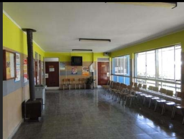
REPARACIÓN CESFAM COMALLE
