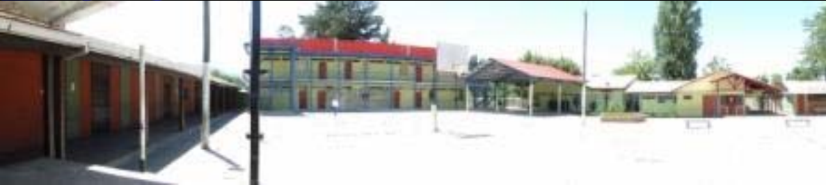
REPARACIÓN ESCUELA COMALLE
