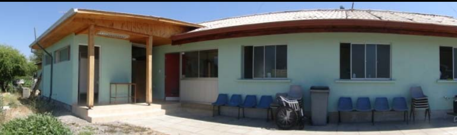
REPARACIÓN POSTA DE SALUD RURAL SAN BLANCA
